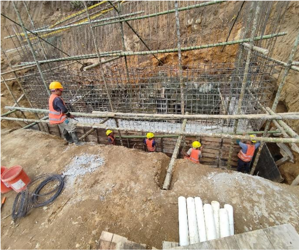
Dotación del equipo de protección personal a los trabajadores.
