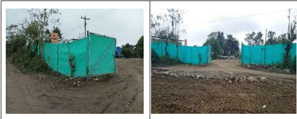
Cerramiento con yute área donde se almacena material pétreo y campamento
