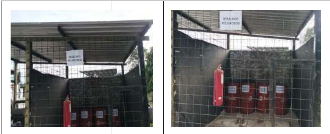
Cubeto construido en el campamento - Suntrac
